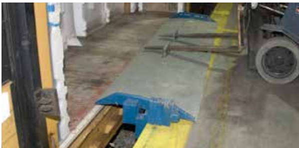
Colocación de Placa de Ferrocarril
